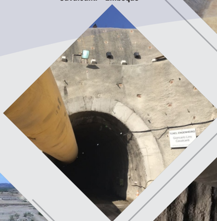
Túnel Eng. Giancarlo Lins Cavalcanti - Emboque
